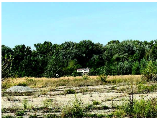
Csapadékvíz átemelő épülete
